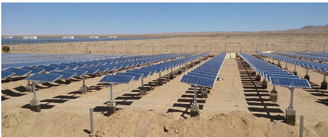
1.2 сурет - Көлбеу модульдері бар горизонтальді бір осьті трекерлер (HTSAT)
