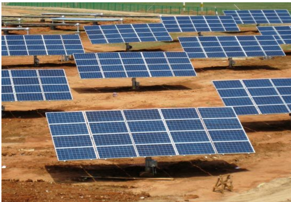
1.5сурет - Екі осьтік трекер Tip-Tilt (TTDAT)
